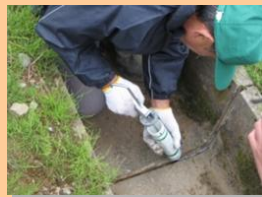
■ 水路の老朽化箇所の補修
