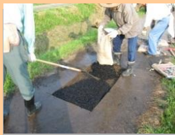
■ 農道舗装の補修
