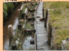
■ 水田魚道の設置
