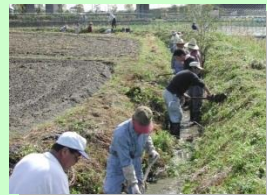
■ 水路の保全管理
