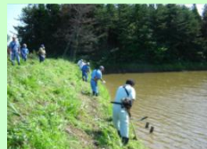
堤体の草刈り等によるため池の保安全管理
