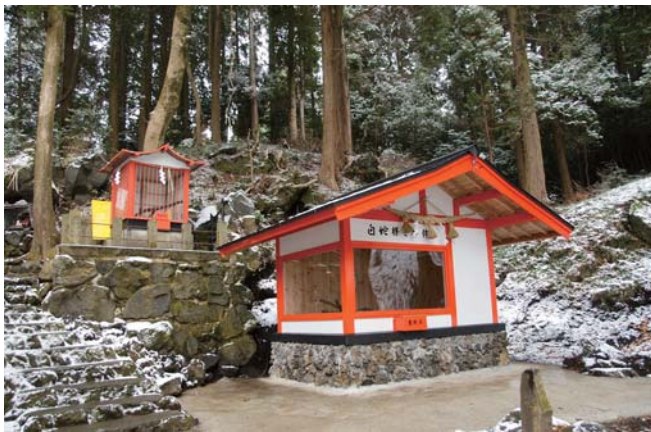
▲完成した蛇舎
