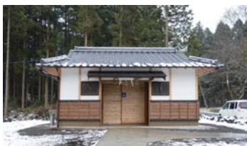
▲完成したトイレ
