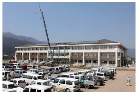
▲建設が進む新阿蘇中学校
