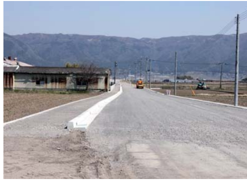
▲工事が進む幹線道路
