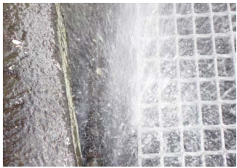
▲破裂した水道管。
