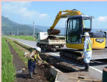
▲狩尾地区で道路沿いの土砂撤去を行う作業員
