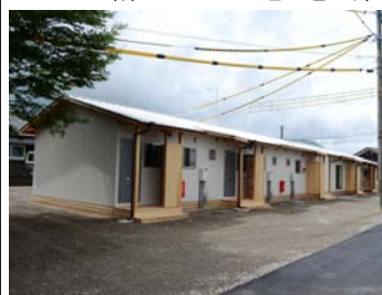
▲8月末に完成した仮設住宅
