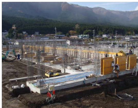
▲小里団地建設状況
