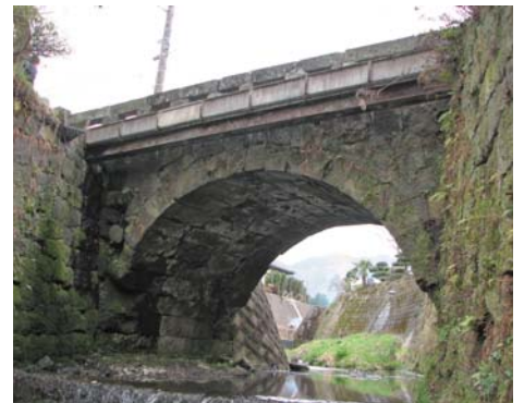
現在も生活道路となっている天神橋 一の宮町坂梨地区
