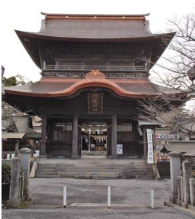
国指定重要文化財・阿蘇神社 現在、防災設備の整備が進む
