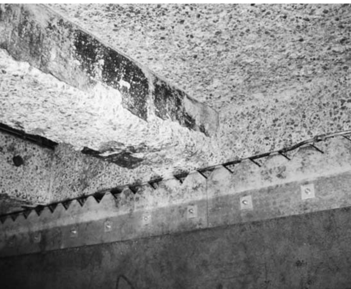
老朽化した下水道処理施設内
