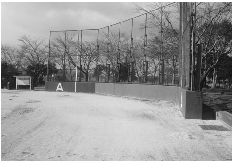
改修予定のバックネット(一の宮運動公園)
