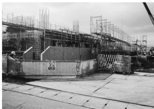
建設中の池尻団地
