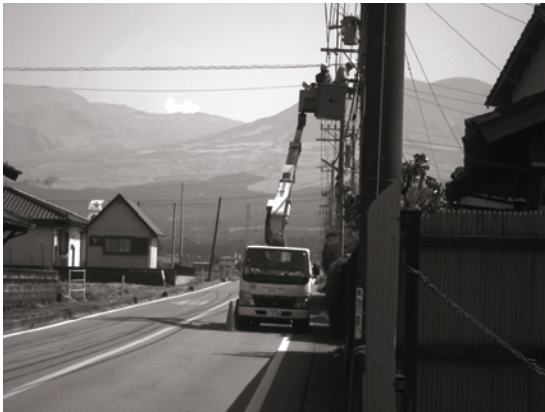
端末機配線工事
