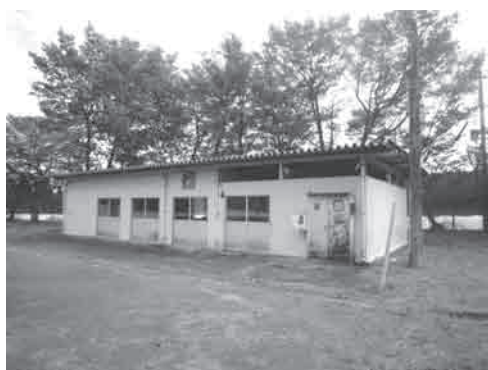
波野総合グラウンド管理棟
