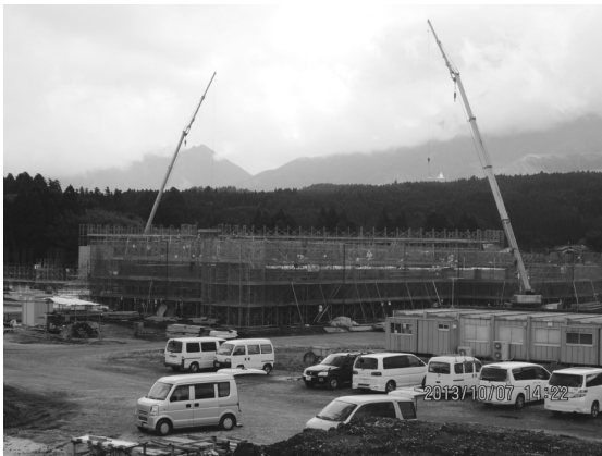
新病院建設現場
