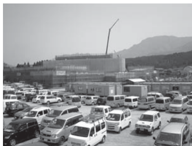
病院建設現場
