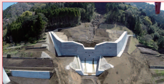
東手野川2砂防堰堤（3月完成）
