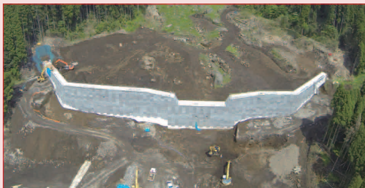
坂梨砂防堰堤（7月完成予定）
