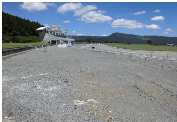
復旧工事中の農村公園あぴか
