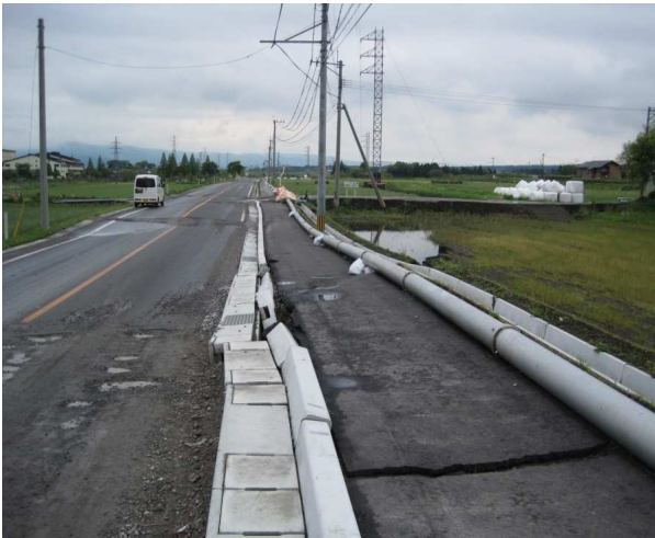
上水道仮設管の布設状況(阿蘇西小学校前)
