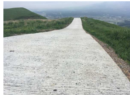
牧道整備（復旧後）
