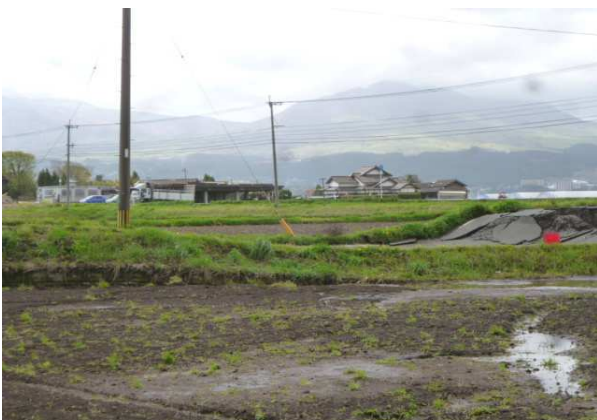
【復旧前(被災写真)】
