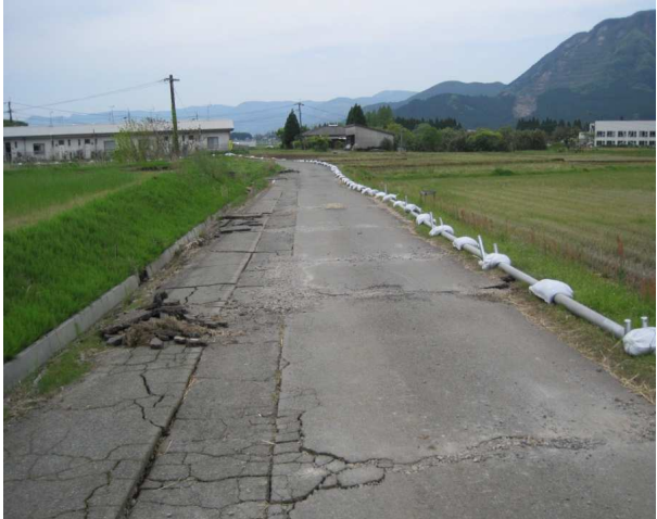
赤水簡易水道仮設管布設状況
