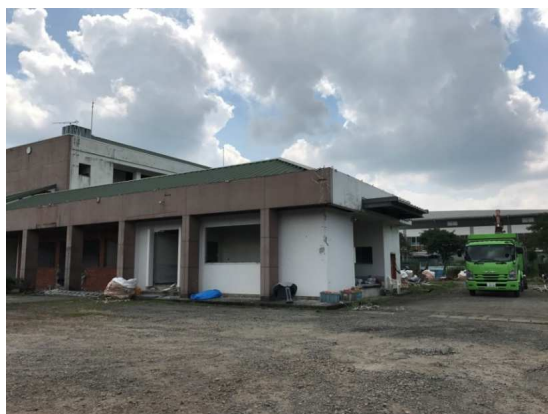
解体途中の阿蘇西小学校
