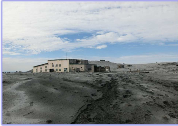
【爆発的噴火後（被災状況）】
