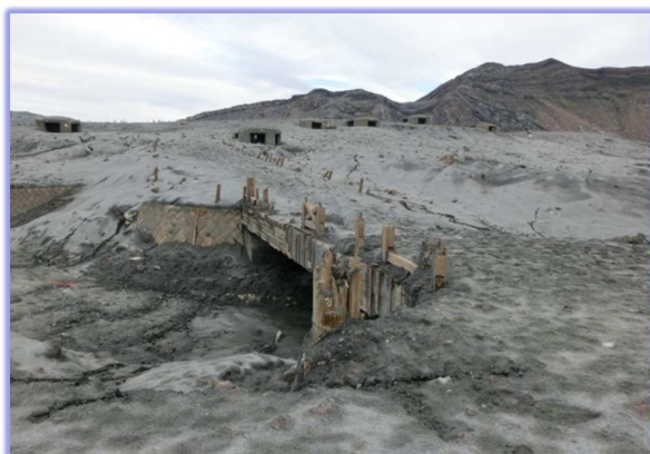
【爆発的噴火後（被災状況）】
