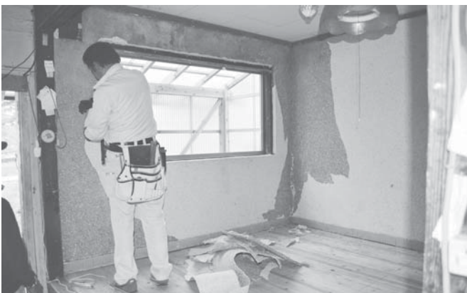
住宅改修工事風景
