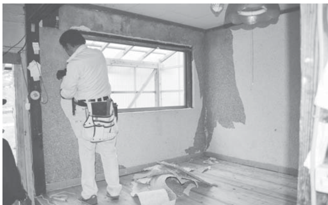
住宅改修工事風景
