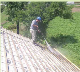
新築、リフォームの際、屋根、外壁窓周りの水樹検査をいたします。
