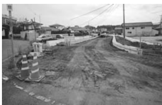
阿蘇医療センター進入路工事
