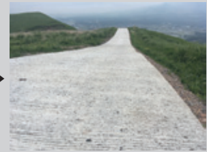
実施後 舗装され利用可能となった牧道
