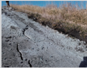
実施前 亀裂により通行できなくなった牧道
