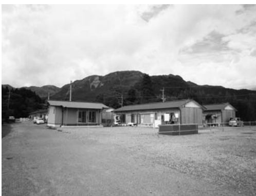
仮設住宅（旧阿蘇北中学校跡地）
