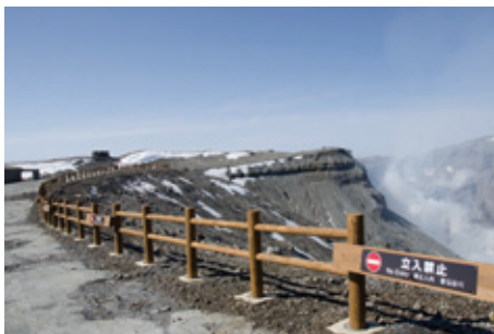
修復した転落防止柵
