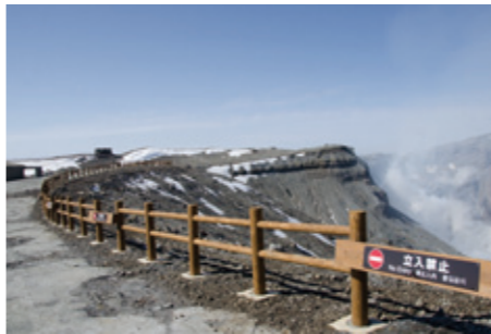
修復した転落防止柵
