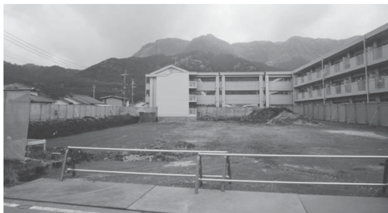
工事中の災害公営住宅新小里団地D棟
