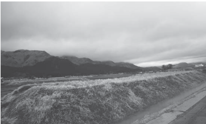
農地災害復旧工事箇所
