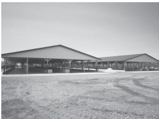
建設中の牛舎
