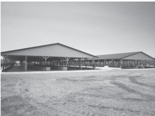
建設中の牛舎
