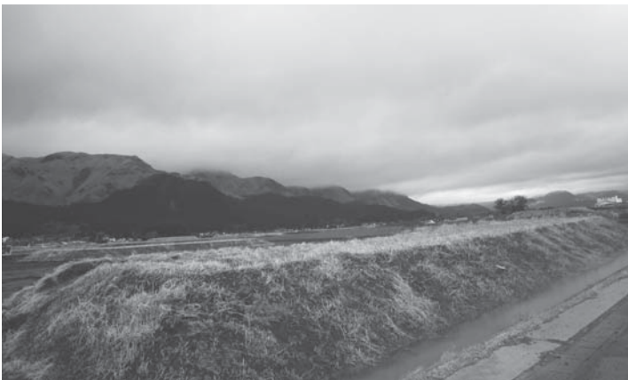
農地災害復旧工事箇所
