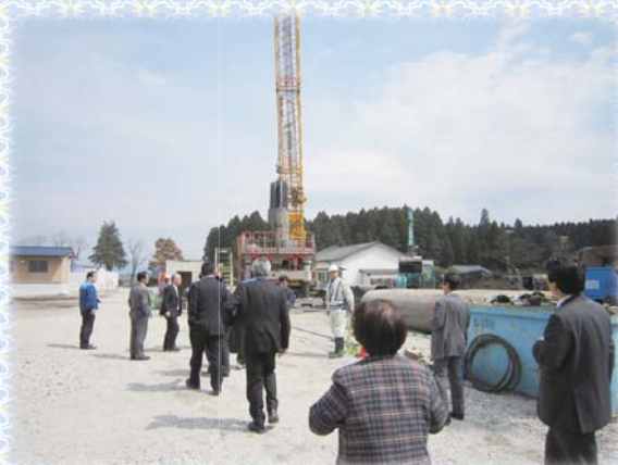
文教厚生常任委員会 阿蘇西小学校校舎等災害復旧工事現地視察
