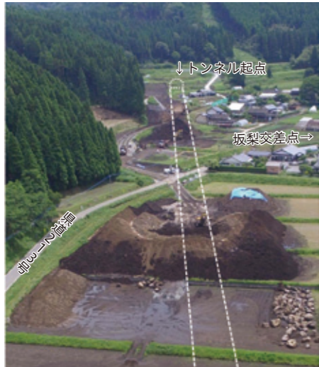
②坂梨側坑口付近
