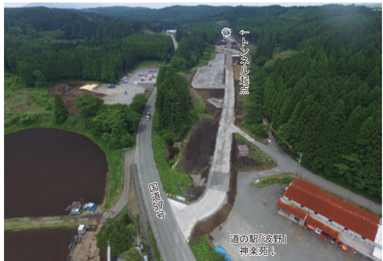
①波野側坑口付近
