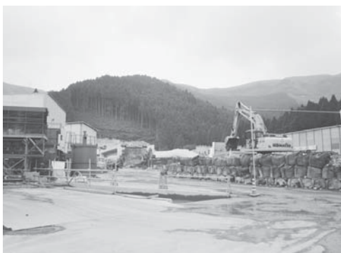
工事中の二重峠トンネル（阿蘇口側）
