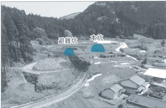
坂梨側坑口付近
