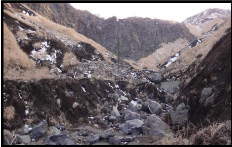
治山整備(復旧前)【東小堀A】
