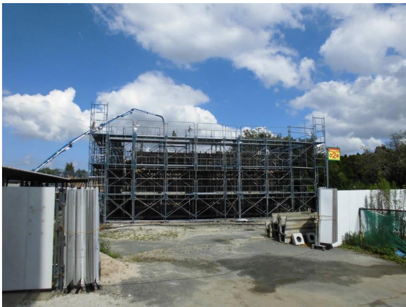
建築途中の阿蘇西小学校
