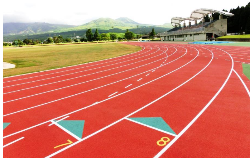
復旧工事が完了した農村公園あぴか
