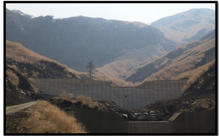
治山整備(復旧後)【東小堀A】
