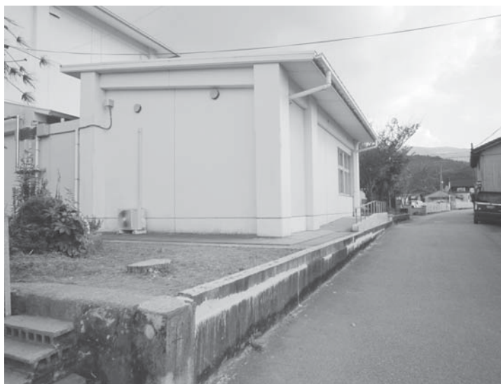
撤去された阿蘇小学校のブロック塀
