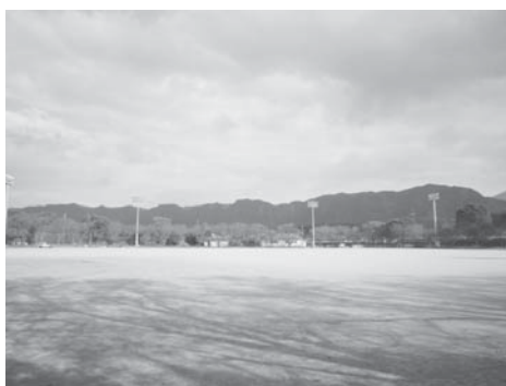
電気設備等を改修する「一の宮運動公園」
