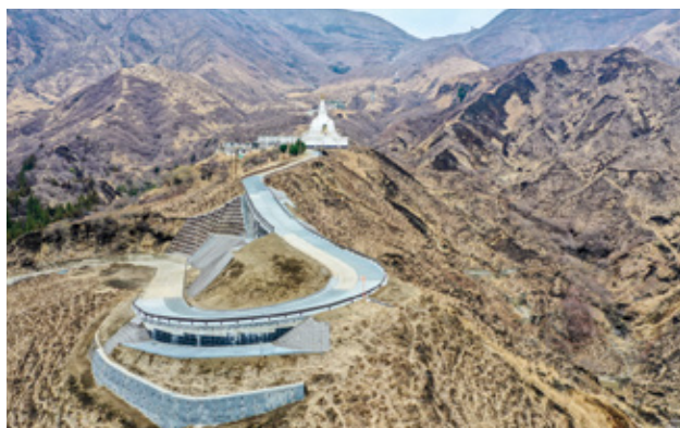
修復された市道仙酔峡線
