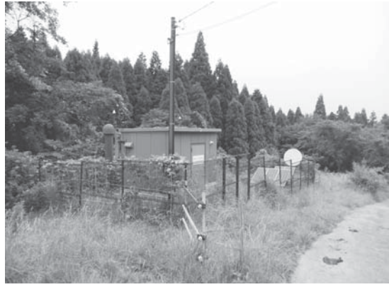
国立研究開発法人防災科学技術研究所の観測施設（二塚牧野内）
