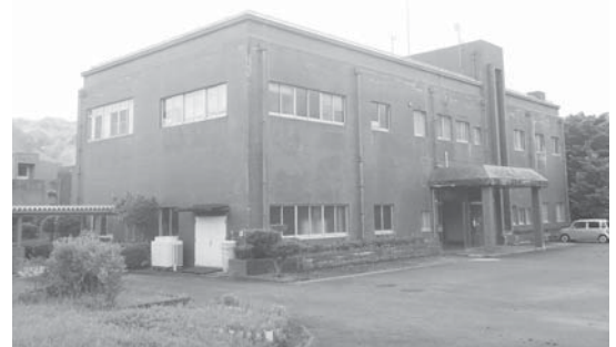
浄化センター（管理棟）
