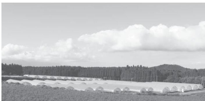
大蘇ダムより水供給を受けている「荻岳ハウス団地」
