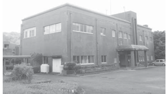
浄化センター（管理棟）
