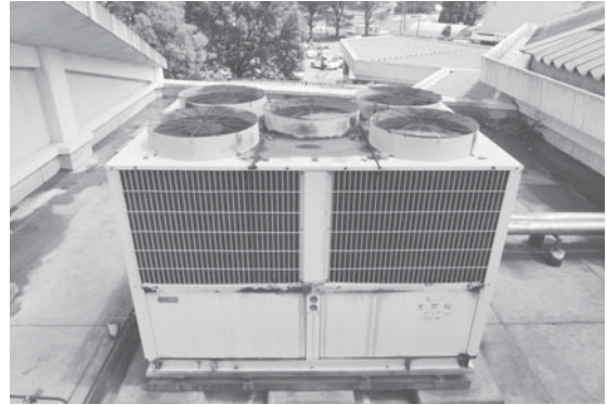
改修されるアゼリア21空調設備
