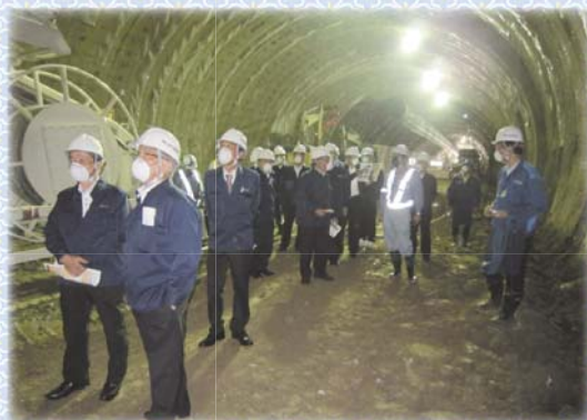
国道57号滝室坂トンネル現地視察
