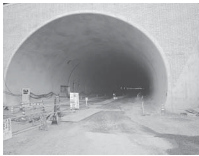
国道57号復旧ルート (阿蘇口側本坑トンネル)
