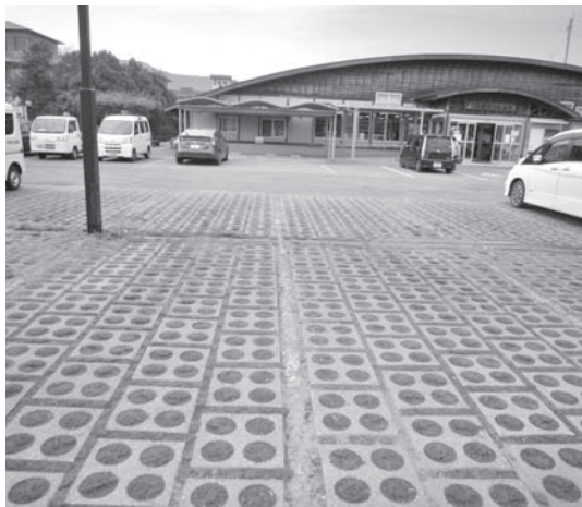
内牧支所 緑化ブロックの駐車場
