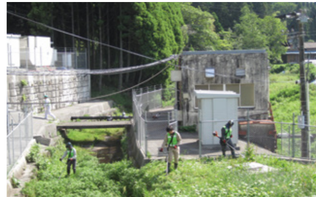
的石地区・殿塚水源地区周辺の除草清掃作業を行う水道工業者
