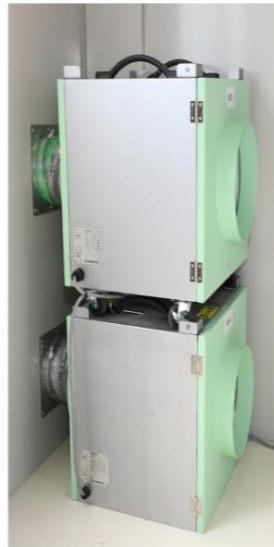
(左) ハウス室内 ※イメージ図、(右) 抗ウイルスHEPAフィルター内蔵換気装置
