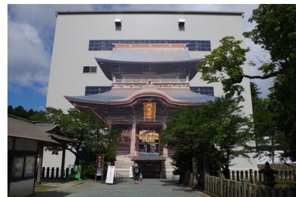
楼門の素屋根完成 (フォトモンタージュ施工) 56
