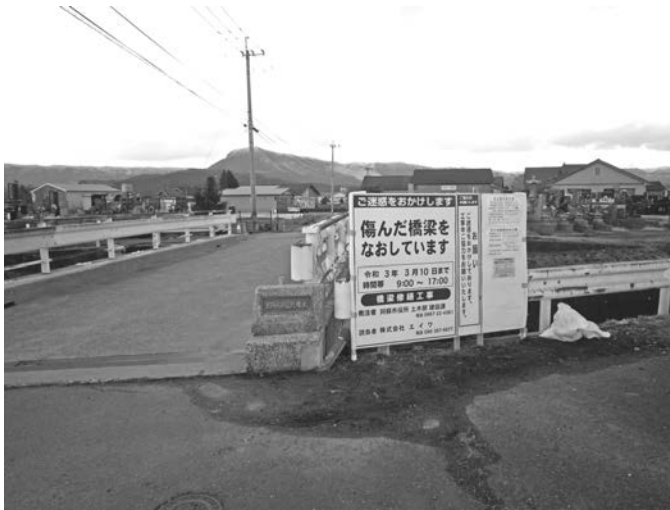
工事中の成川新川橋
