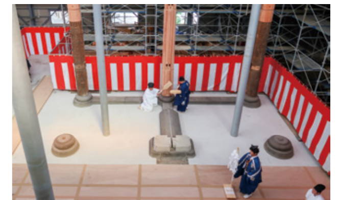
素屋根の中で立柱の儀式を執り行う工事関係者
