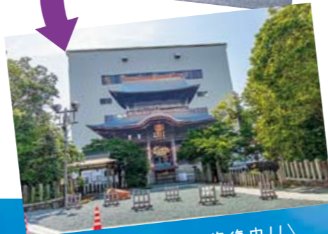
楼門も修復中!!
