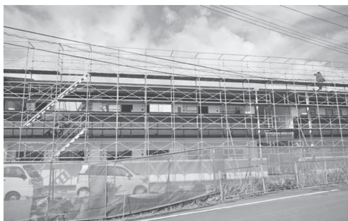
市営住宅赤水西団地建設工事現場
