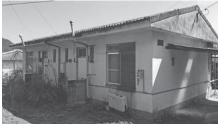
築年数が経過した市営住宅
