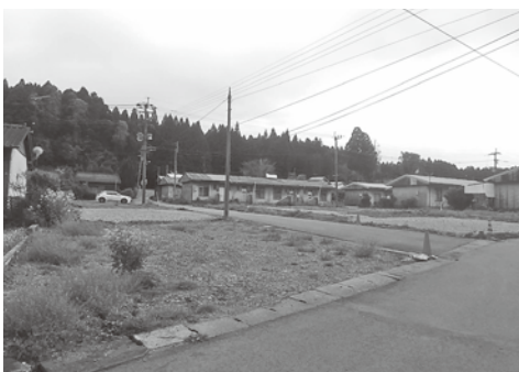
坊中南住宅解体跡地
