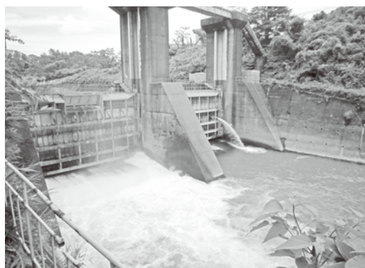
九電の調整堰
