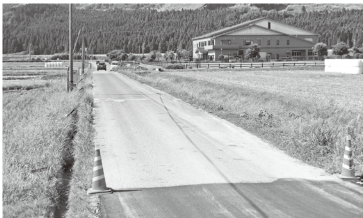
蘇水館に向かう市道の改良箇所
