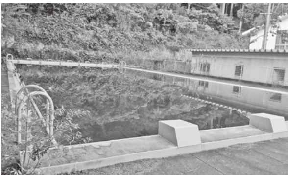
使用不可となった波野中学校プール
