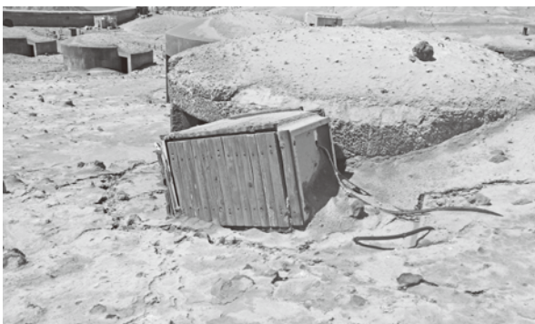
火口の倒壊したガス検知器
